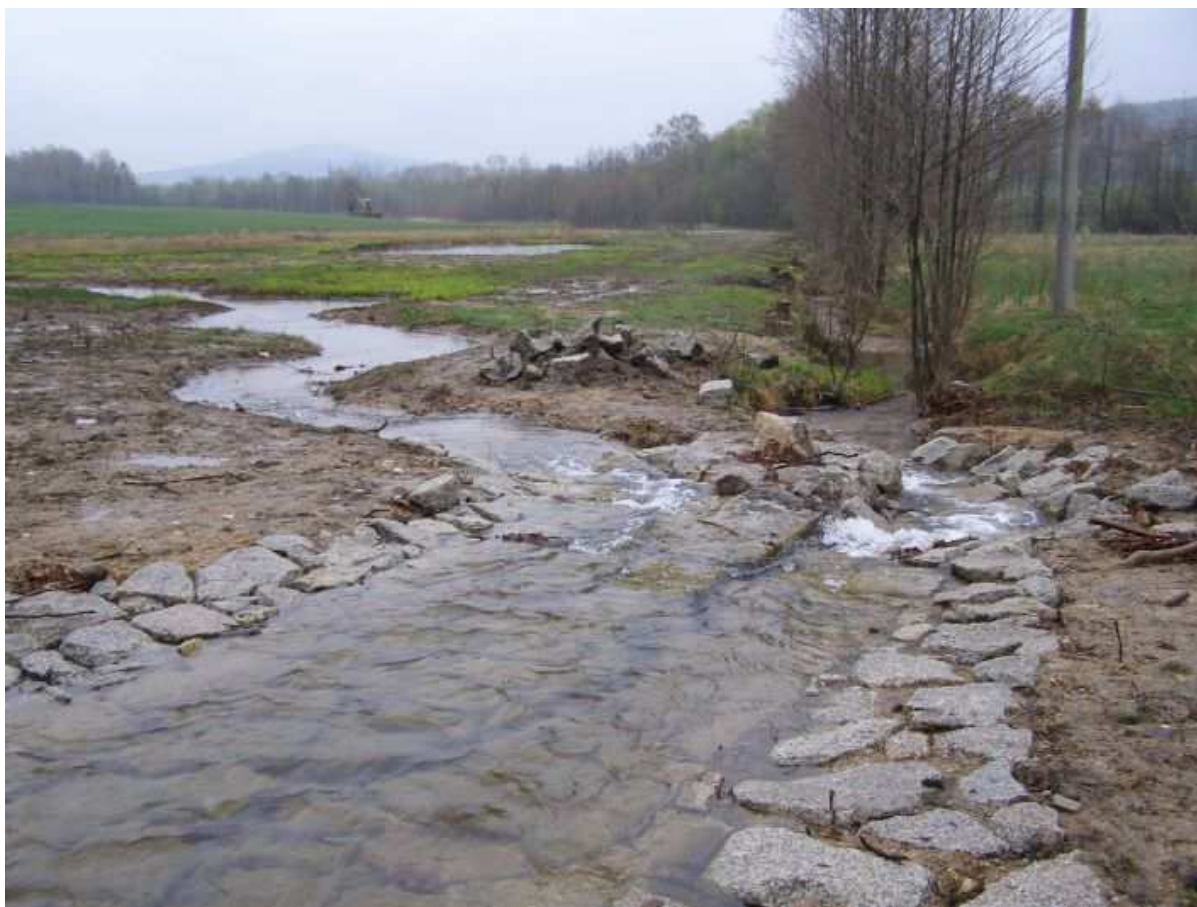
Začátek revitalizovaného úseku Holubího potoka s rozdělovacím objektem
