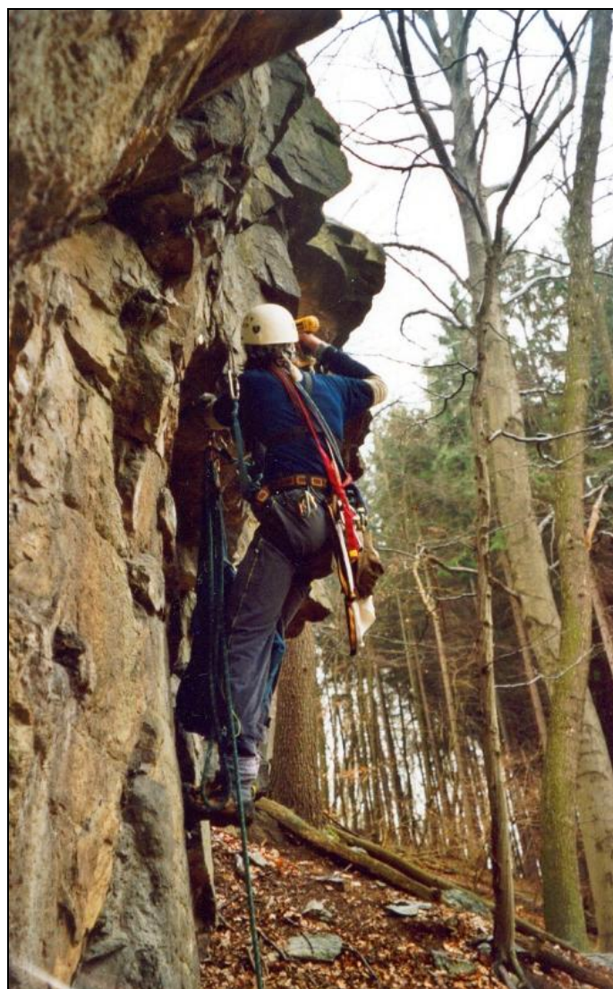
Práce v údolní stěně Větrné hůrky
